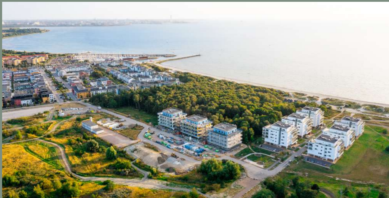
Flygvy sommaren 2024. Det fjärde och femte Kvirkelhuset kommer att komplettera raden fint. Mellan tredje och fjärde huset anlägger vi en mindre park.
